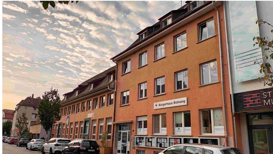
Straßenansicht Vordergebäude Griegstraße
