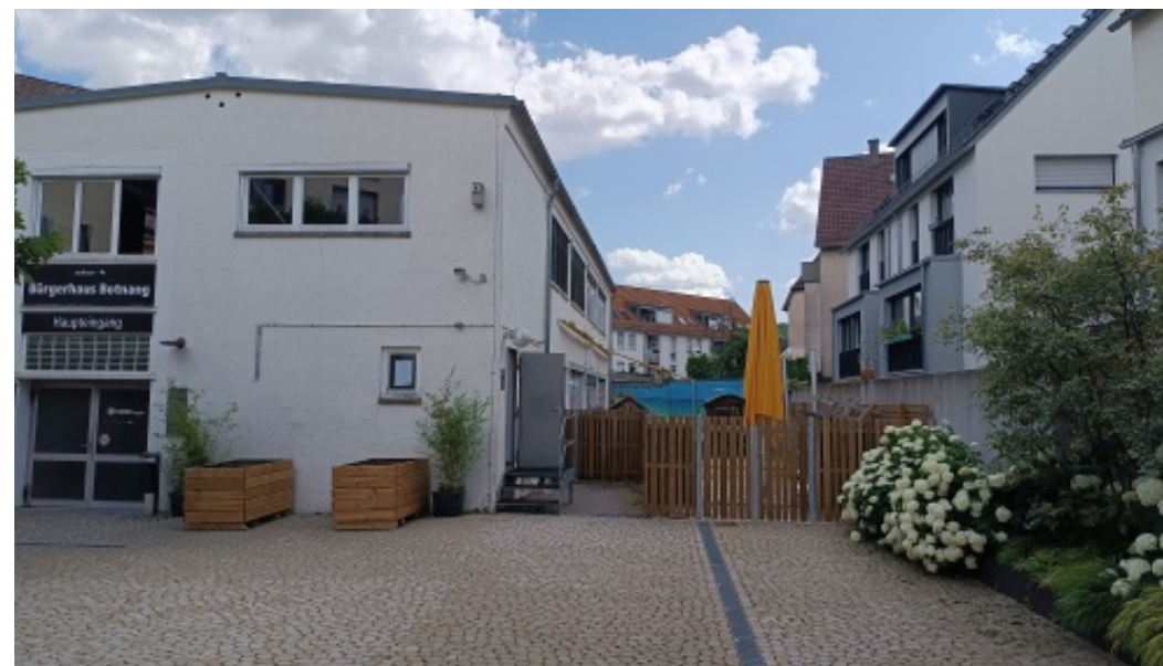
Ansicht Außenbereich Kita und Eingang Café Intus und Musiksaal
